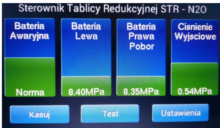
Rys. 5. Widok ekranu głównego panelu sterowania tablicy z zasilaniem awaryjnym.
